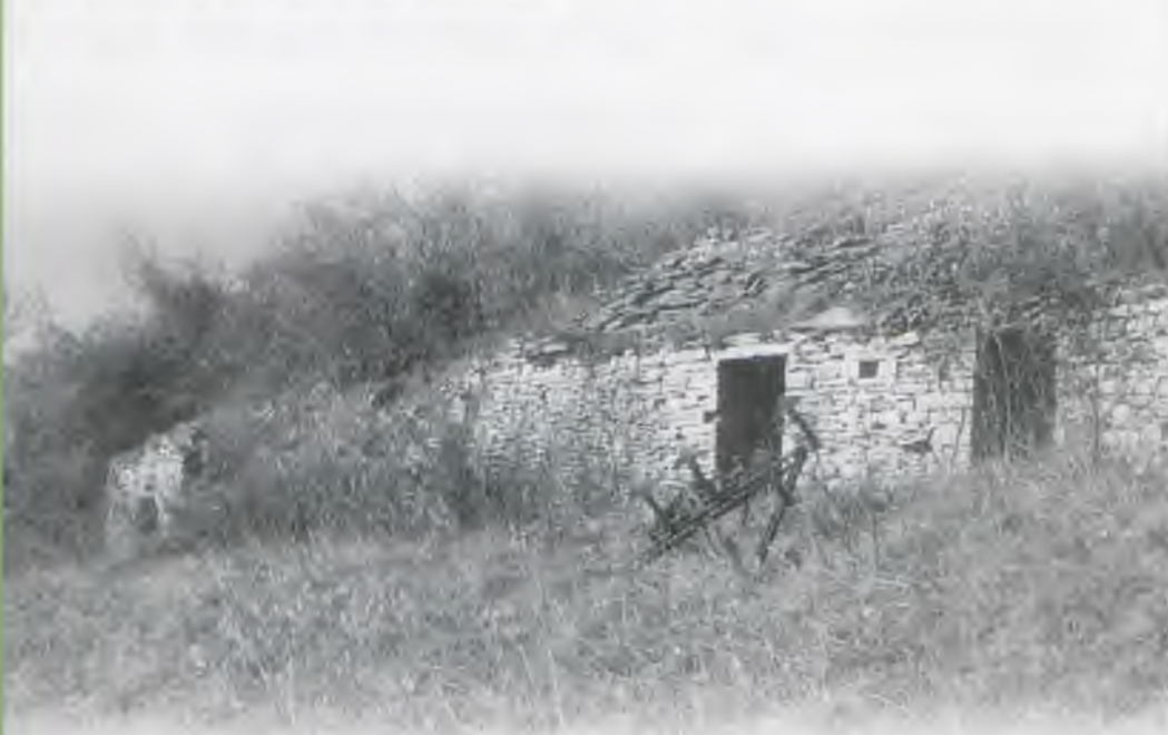
Les cabanes du Roblat à Foleymioux, dans un mur de soutènement. L'une d'entre elles abrite une fontaine.
